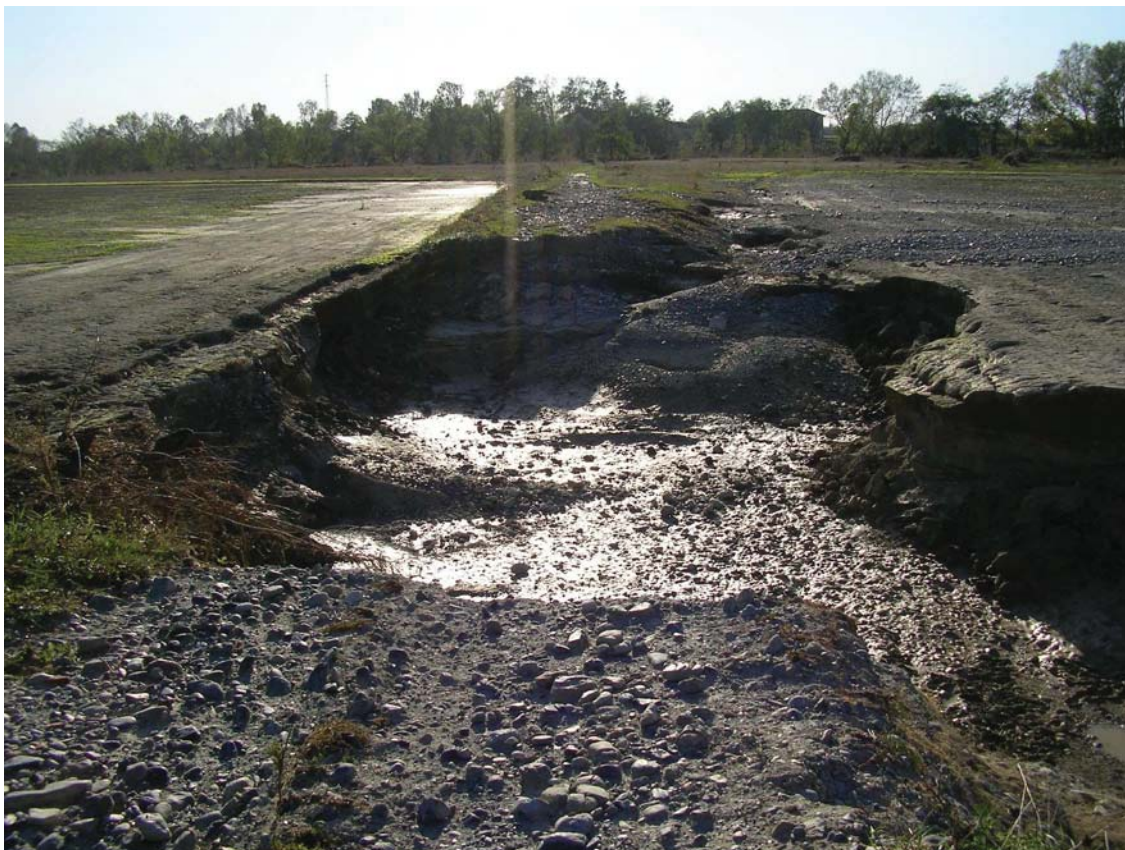
Figura 33- Effetti dell'erosione a seguito dell'evento alluvionale nei pressi di C.na San Michele
